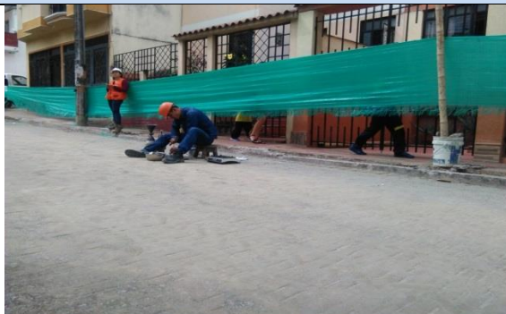
Ilustración 35 Toma de densidades para la base granular.
