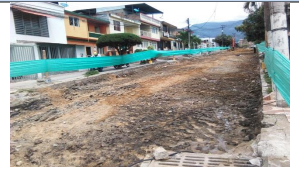
Ilustración 78. Finalización de actividades de cajeo
