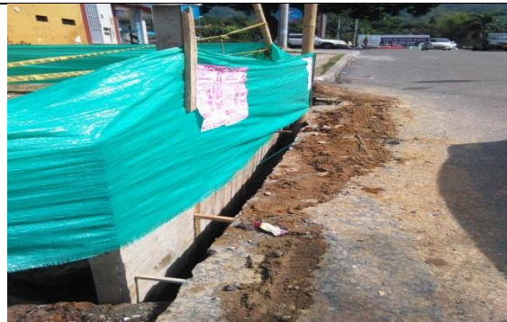
Ilustración 26. Construcción de viga de separación.
