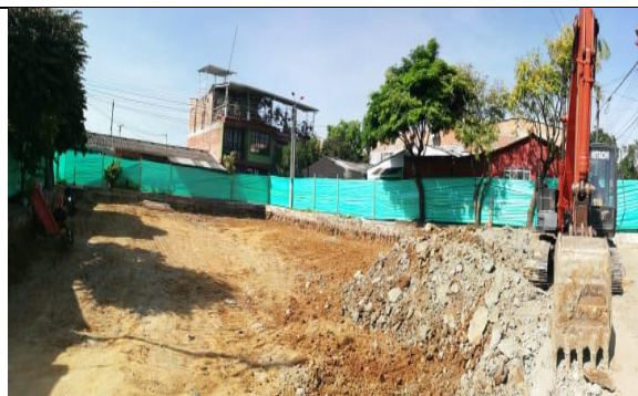
Ilustración 53. Excavación mecánica cajero de vía.
