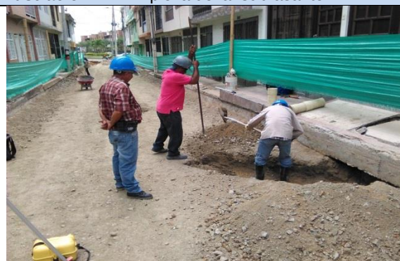
Ilustración 22. Limpieza de la subrasante.
