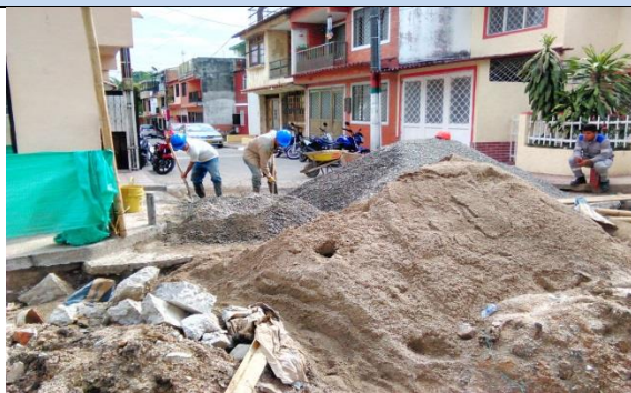
Ilustración 37. Revestimiento de domiciliarias de alcantarillado.
