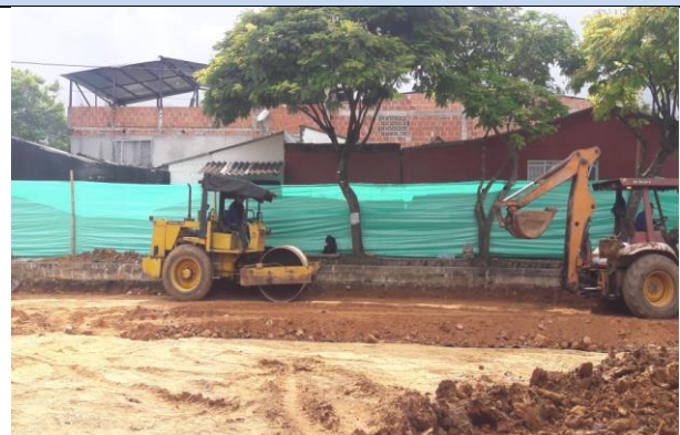
Ilustración 60. Recebo compactado.
