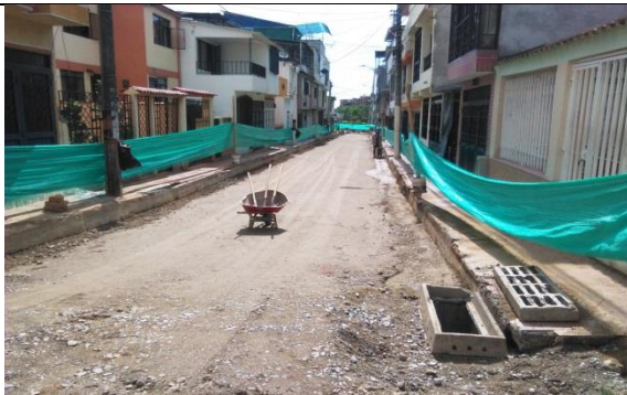
Ilustración 25. Nivelación manual de costados de la vía.
