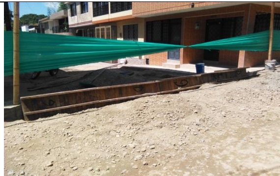
Ilustración 14. Construcción viga de separación.
