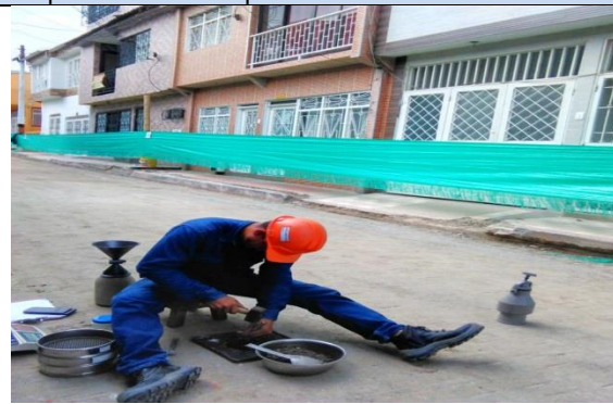
Ilustración 34 Toma de densidades para la base granular.
