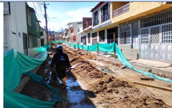
Ilustración 36. Llenos en recebo de la excavación de la red hidráulica.
