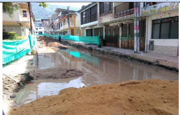
Ilustración 44. Daños de domiciliarias durante cajeo.
