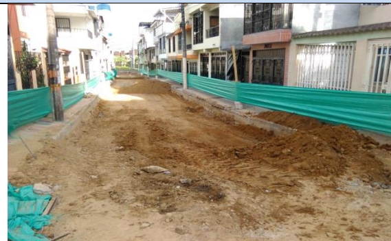
Ilustración 22. Limpieza de la subrasante.
