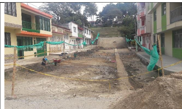
Ilustración 105. Personal del Ibal realizando reposición de domiciliarias de acueducto.
