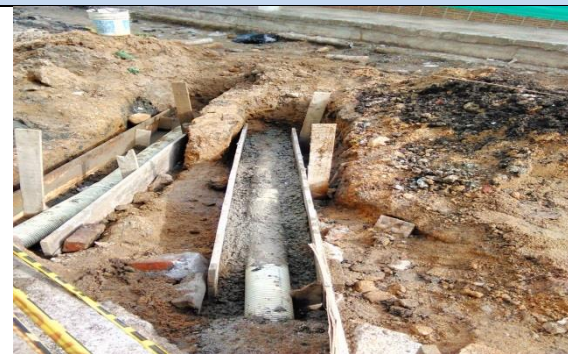
Ilustración 38. Revestimiento de domiciliarias de alcantarillado.
