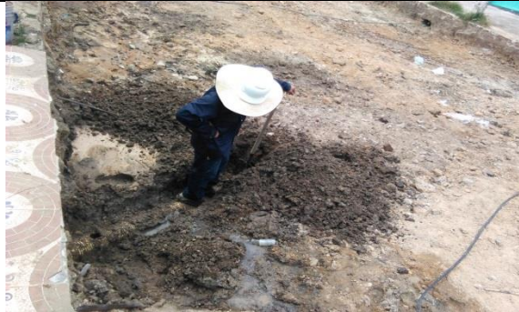
Ilustración 75. Reparación domiciliarias alcantarilado
