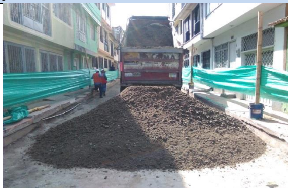
Ilustración 27. Conformación de la vía en subbase granular.
