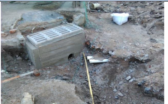
Ilustración 46. Desempate de la tubería principal de acueducto.
