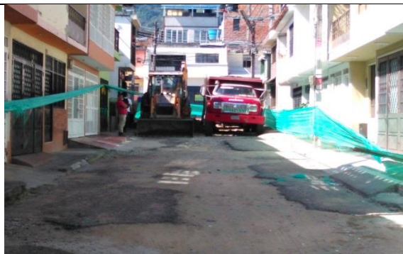
Ilustración 42. Inicio cajeo de la vía.
