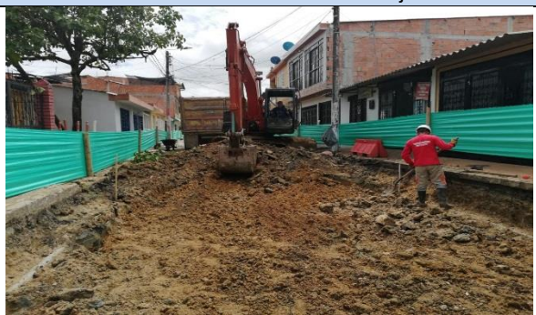
Ilustración 70. Excavación mecánica cajeo de vía.
