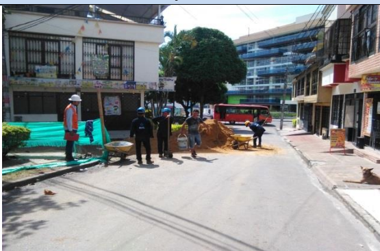
Ilustración 43. Inicio cajeo de la vía.
