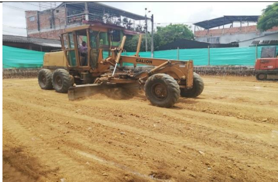
Ilustración 55. Nivelación de subrasante.
