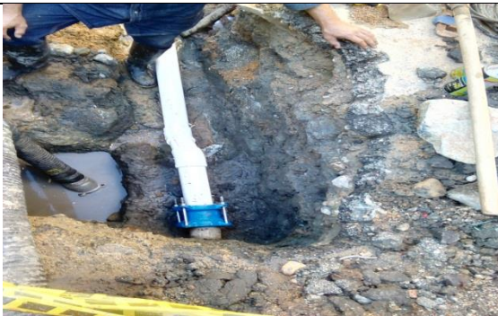
Ilustración 49. Empalme de la red hidráulica.
