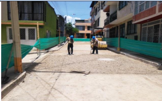
Ilustración 13. Nivelación de pozos y sumideros.
