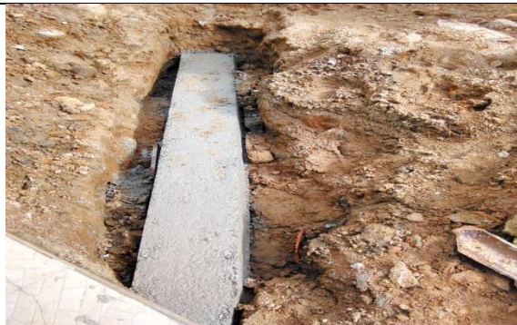
Ilustración 38. Revestimiento de domiciliarias de alcantarillado.
