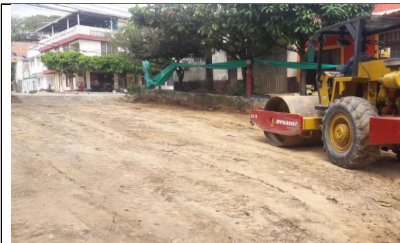
Ilustración 103. Compactación de subrasante.
