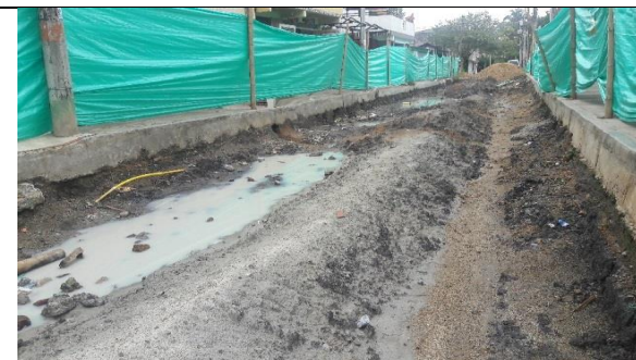
Ilustración 63. Material pendiente por retirar por el lbal proveniente de la reposición de acueducto.
