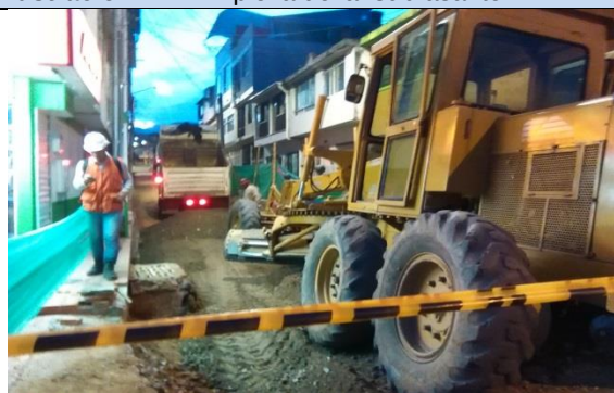
Ilustración 21. Limpieza de la subrasante.
