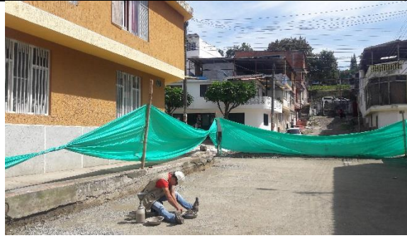
Ilustración 96. Extendida de material granular subbase.
