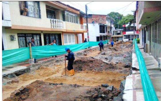
Ilustración 50. Llenos con recebo en las excavaciones de la red hidráulica.
