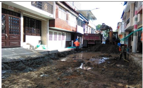
Ilustración 44. Daños de domiciliarias durante cajeo.
