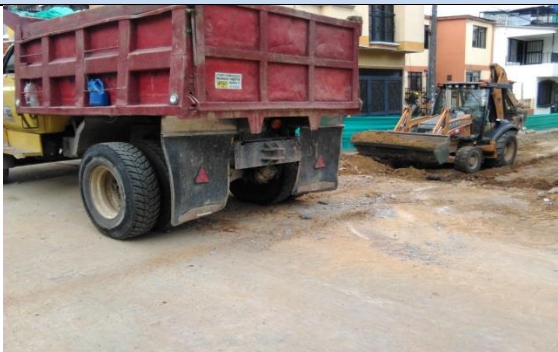
Ilustración 19. Excavación para conexión de sumideros.
