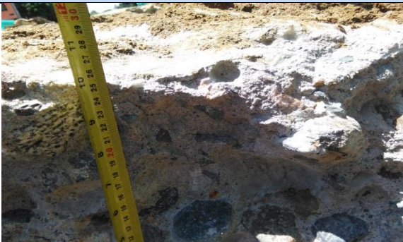
Ilustración 77. Demolicion de pavimento en concreto rigido.
