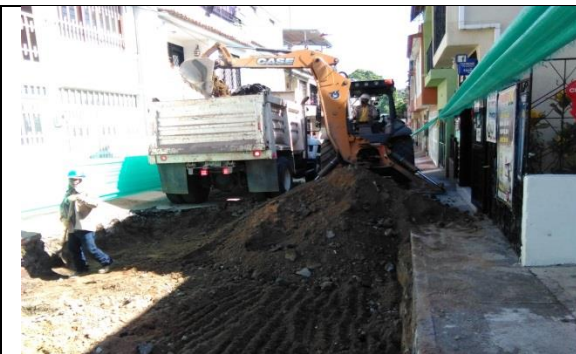
Ilustración 43. Inicio cajeo de la vía.
