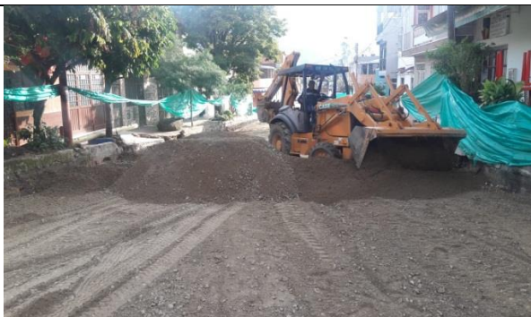
Ilustración 104. Suministro e instalación de subbase granular.
