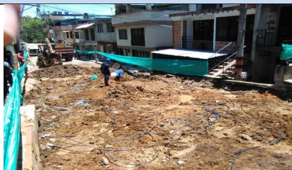
Ilustración 83. Avistamiento de red hidráulica y acometidas
