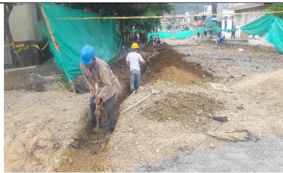
Ilustración 102. Reposición de la red de acueducto, personal del Ibal.
