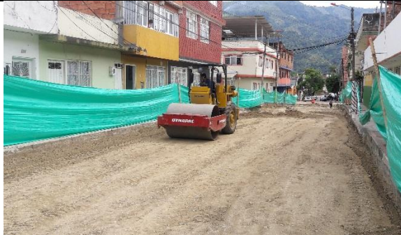
Ilustración 95. Retiro de fallos encontrados en la subrasante.
