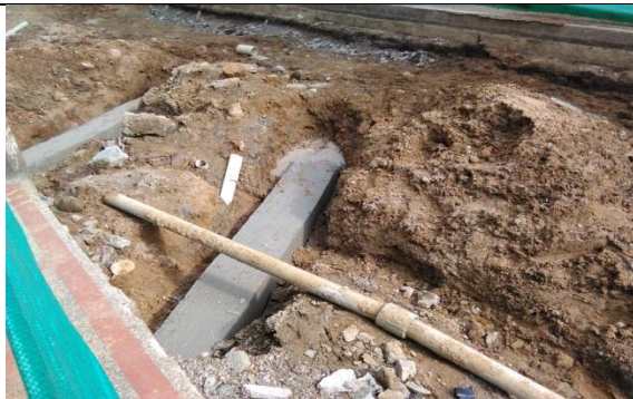
Ilustración 37. Revestimiento de domiciliarias de alcantarillado.
