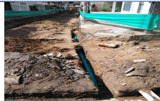
Ilustración 37. Intervención del ibal en la red de acueducto.
