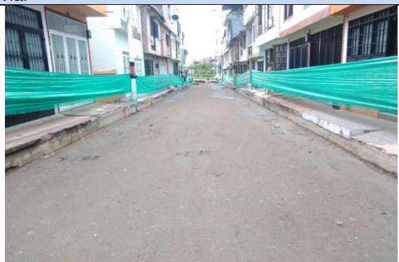
Ilustración 25. Nivelación manual de costados de la vía.
