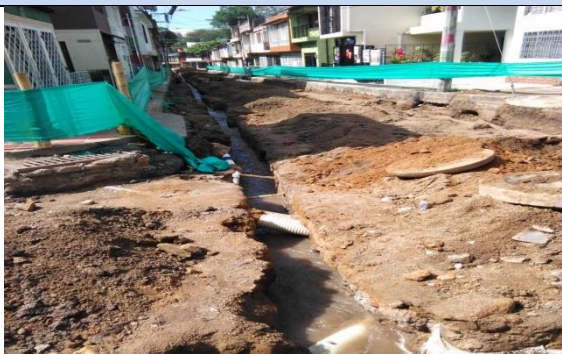
Ilustración 38. Excavación para profundización de red hidráulica.
