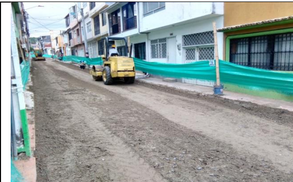
Ilustración 31. Compactación de la base granular.
