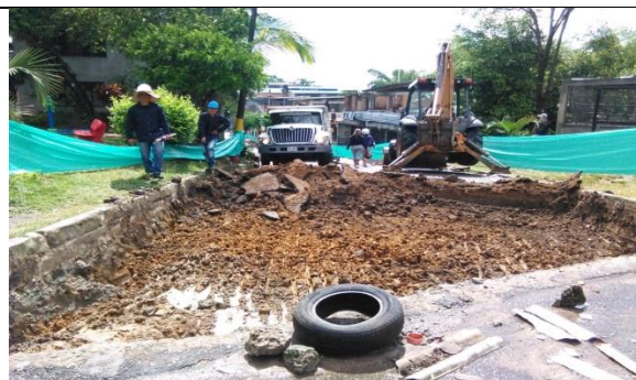
Ilustración 82. Inicio de cajeo en la via
