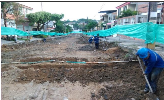
Ilustración 79. Intervención del lbal en las red de acueducto
