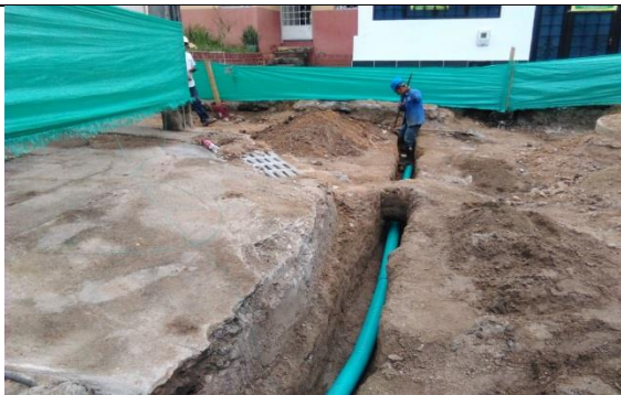
Ilustración 36 Mantenimiento de redes de telefonía.
