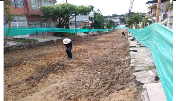
Ilustración 76. Reparación domiciliarias acueducto
