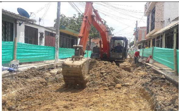
Ilustración 70. Excavación mecánica cajeo de vía.
