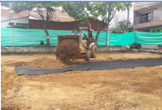
Ilustración 57. Suministro e instalación Geotextil NT-2500
