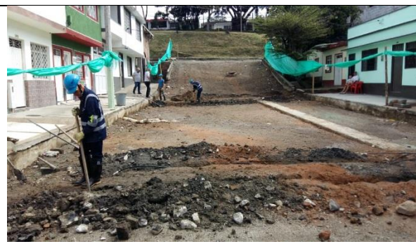
Ilustración 106. Excavación manual para reposición de domiciliarias de acueducto.
