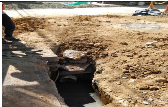
Ilustración 20. Conexión de sumideros.
