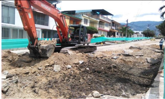
Ilustración 73. Cajeo de la via
