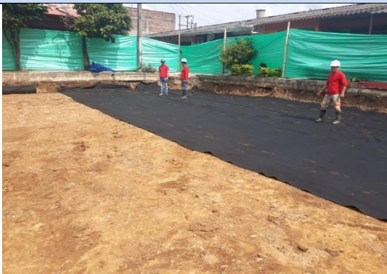
Ilustración 57. Suministro e instalación Geotextil NT-2500
