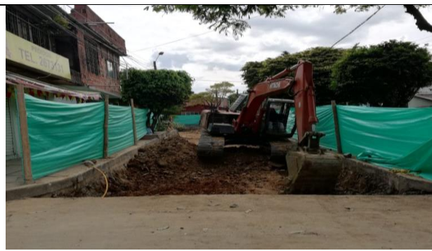
Ilustración 54. Excavación mecánica cajero de vía.
