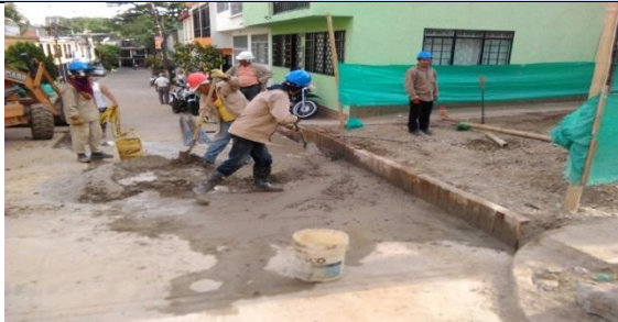
Ilustración 17. Construcción viga de separación.
