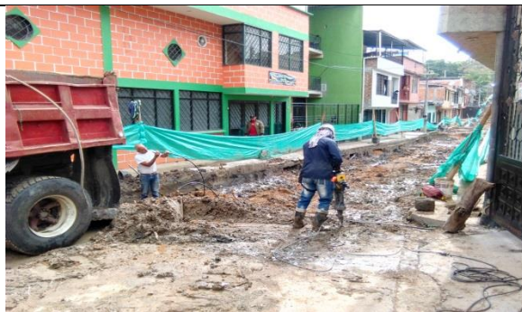
Ilustración 86. Dsemolicion de placa en concreto rigido..
