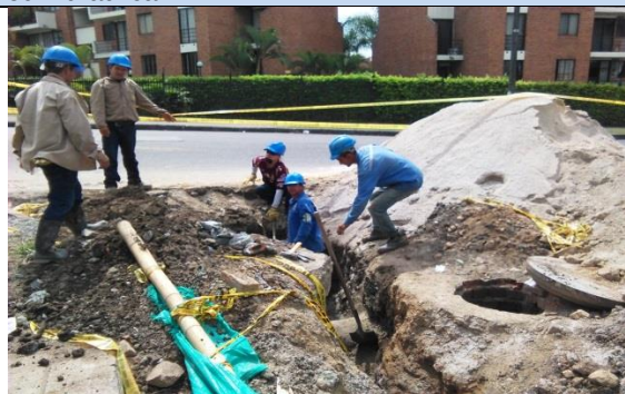
Ilustración 38. Excavación para profundización de red hidráulica.
