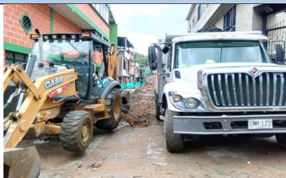
Ilustración 88. Continuación de cajeo
