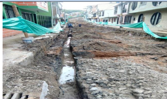
Ilustración 90. Intervención del Ibal en las redes hidráulicas.
