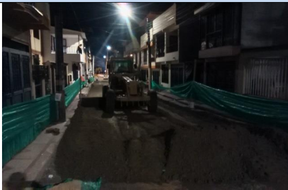
Ilustración 31. Compactación de la base granular.
