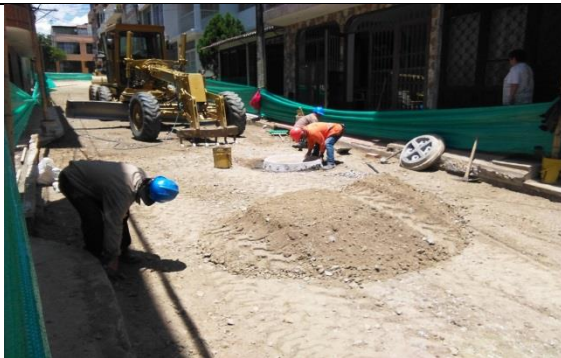
Ilustración 13. Nivelación de pozos y sumideros.
