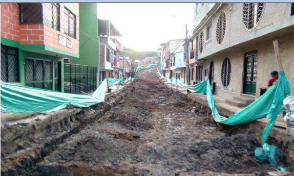
Ilustración 89. Finalización de actividades de cajeo
