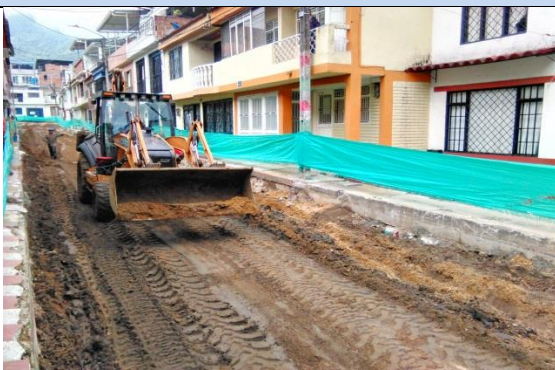
Ilustración 51. Limpieza de la subrasante
