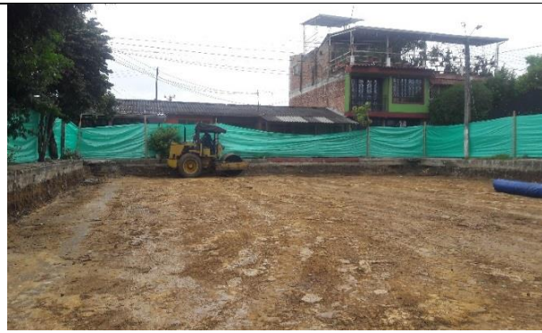
Ilustración 56. Compactación de subrasante.
