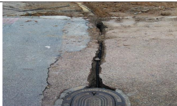
Ilustración 80. Conexio de domiciliarias hidraulucas.
