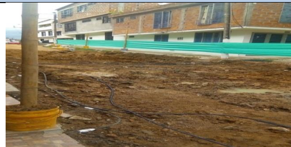
Ilustración 94. Inicio de cajeo de la vía y avistamientos de domiciliaria de acueducto.
