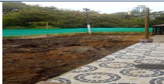
Ilustración 93. Cerramiento de la vía en polisombra
