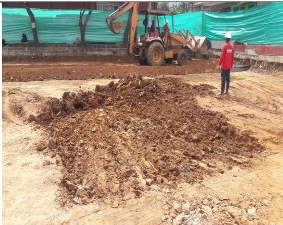
Ilustración 61. Retiro de Fallos.
