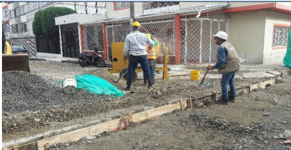
Ilustración 100. Fundida de viga de confinamiento en intersección.
