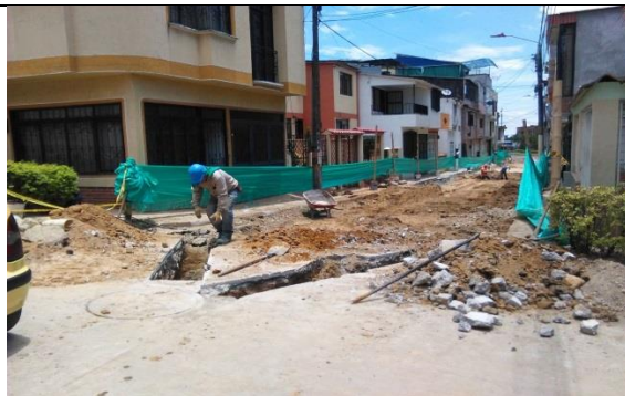
Ilustración 19. Excavación para conexión de sumideros.
