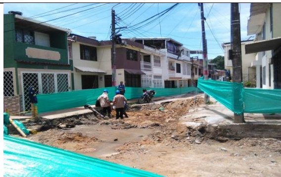
Ilustración 41. Reparación de daño en la red hidráulica.
