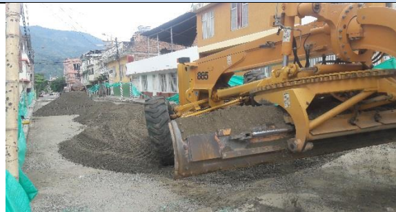
Ilustración 99. Extendida de material granular base.
